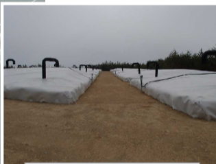
伐採木一時保管槽
