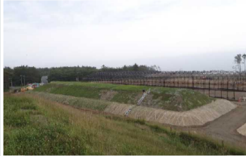
覆土式一時保管施設
