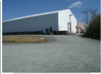
瓦礫保管テント
