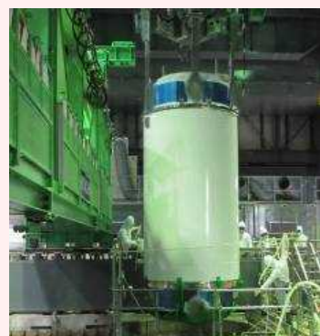
燃料取り出し状況
