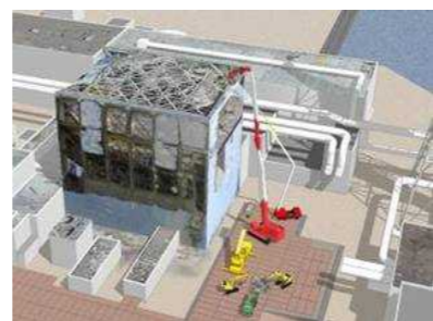
原子炉建屋上部のガレキ撤去
