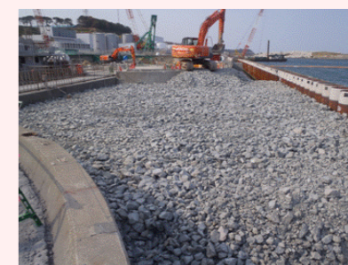
海側遮水壁工事状況 （1号機取水口側埋立状況）
