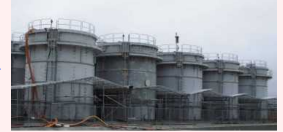
堰カバー設置後
