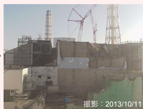
大型ガレキ撤去後
