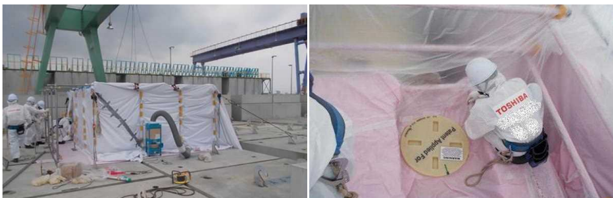
No.172（AJ5）の調査状況、蓋開放はハウス内で適切に換気を行って実施
