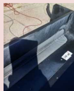
塗装剥離後の一例
