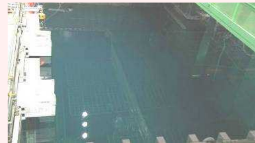
4号機使用済燃料プール内の状況
