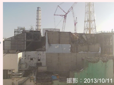
大型ガレキ撤去後
