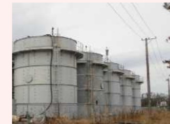
堰カバー設置前
