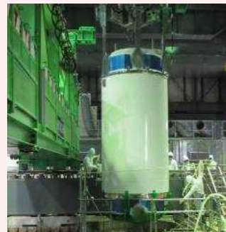
燃料取り出し状況
