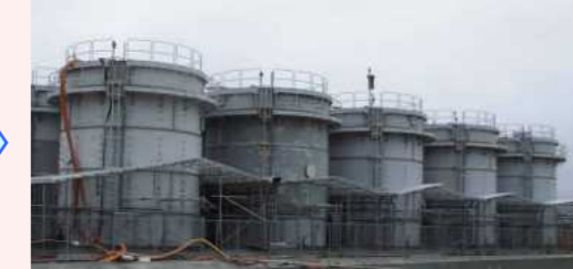
堰カバー設置後
