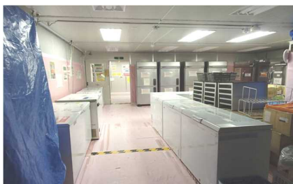
保冷剤冷凍庫の配備
