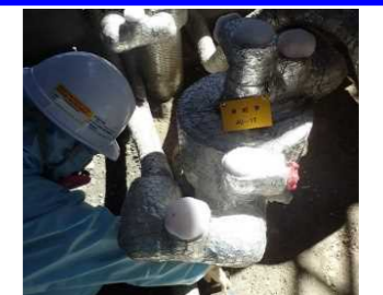
(凍結管への氷の付着状況)
