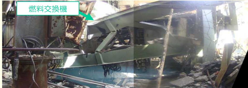
<原子炉建屋最上階ガレキ調査状況（燃料交換機南東部）>
