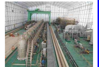
(高性能多核種除去設備)
