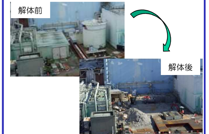
(2号機建屋周辺整備状況)
