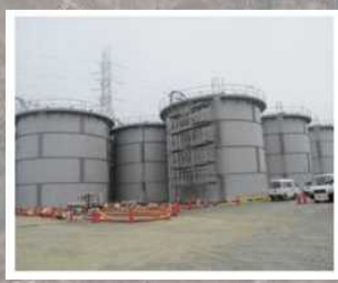
タンクの設置状況
