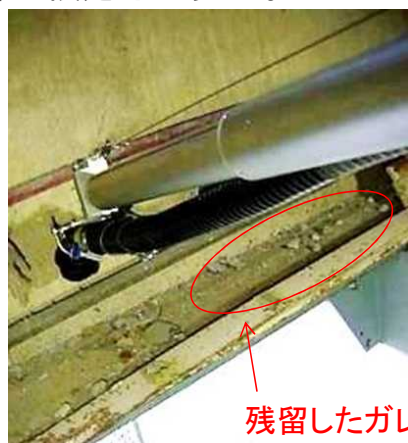
B-2付近の吸引作業状況
