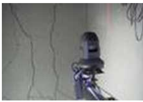
壁面のひび割れ状況
