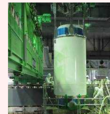
燃料取り出し状況
