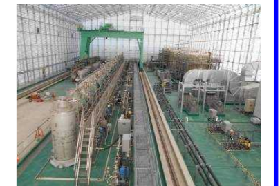
(高性能多核種除去設備)
