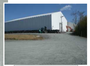
瓦礫保管テント
