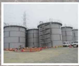
タンクの設置状況
