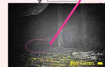
格納容器内調査状況
