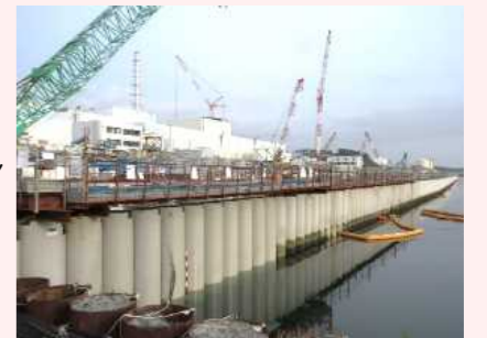
海側遮水壁 鋼管矢板打設完了状況
