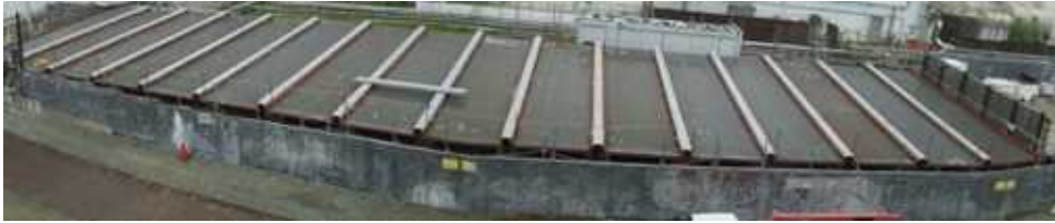
【逆洗弁ピット上部の屋根設置状況】
