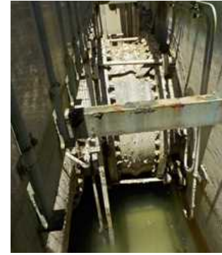
【6月27日移送終了後の配管貫通部（海側）】
