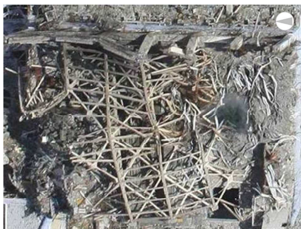
オペフロ大型瓦礫撤去着手前（撮影日2011年3月24日）
