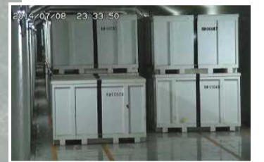
固体廃棄物貯蔵庫
