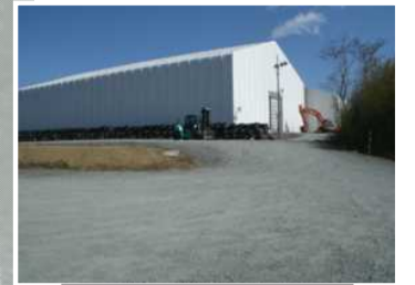
瓦礫保管テント
