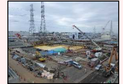
H1東エリア解体後の様子
