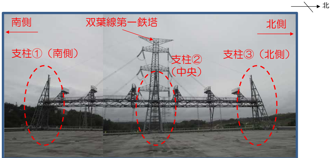
5,6号開閉所屋上から見た引留鉄構の外観
