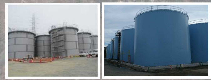
タンクの設置状況
