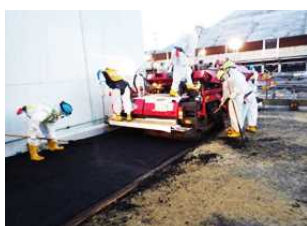
写真① アスファルト舗装
