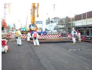
写真② 40mm鉄板敷設
