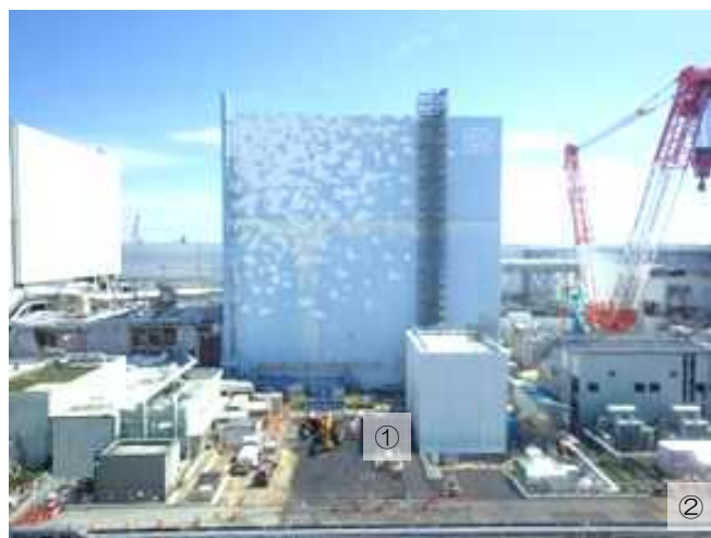
2号機原子炉建屋周辺状況（2016年9月10日撮影）
