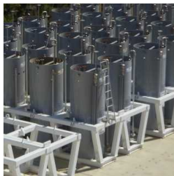
第二セシウム吸着装置 (SARRY) 吸着塔
