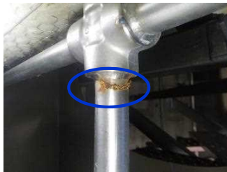
<排ガスフロアA逆止弁ドレン配管>
