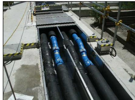
PE管（100A）施工状況＜屋外＞
