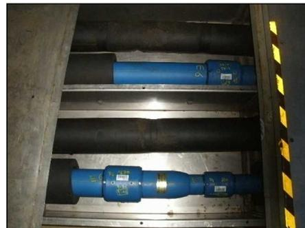
PE管（100A）施工状況
