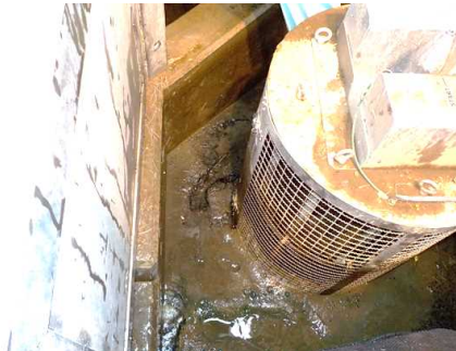
図3 清掃前の状況(7/7) 土砂がヘッドロ状に滞積
