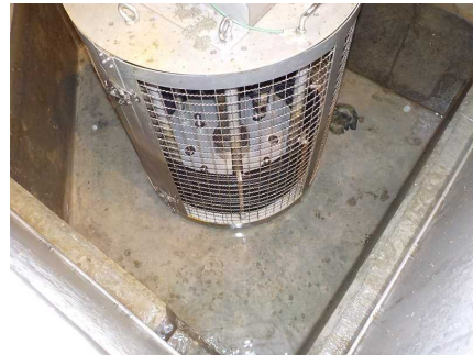
図4 清掃後の状況(7/7)
