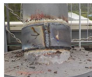
溶接による補修
