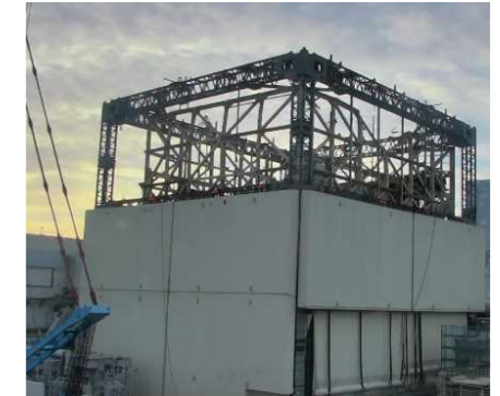
(1号機建屋カバー壁パネル取外状況)
