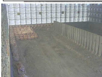
瓦礫保管 テント内
