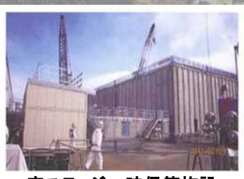
廃スラッジ一時保管施設
