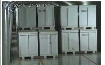
固体廃棄物貯蔵庫
