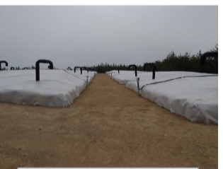
伐採木一時保管槽
