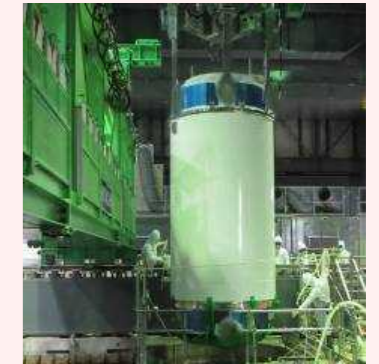
燃料取り出し状況
