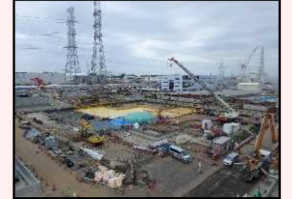
H1東エリア解体後の様子
