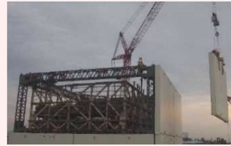
＜壁パネル取り外し状況＞
