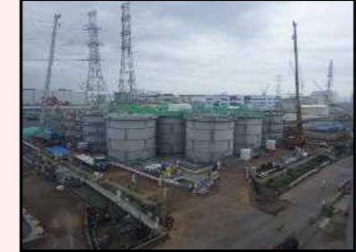
H1東エリア解体開始時の様子
