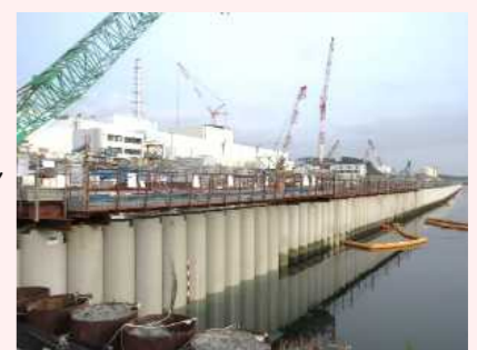
海側遮水壁 鋼管矢板打設完了状況
