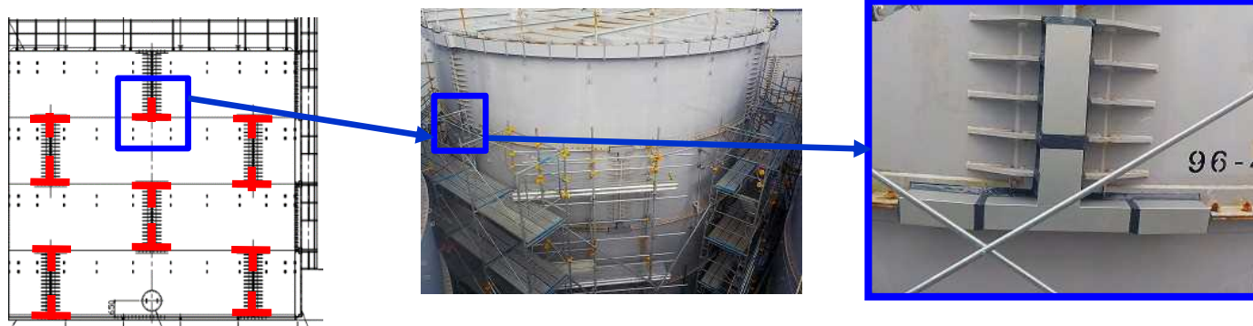
赤線部：補修箇所
