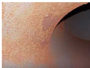
<排ガス補助プロアB入口側煙道>
