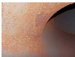
<排ガス補助フロアB入口側煙道>
