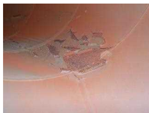
<バグフィルタB出口側煙道>
