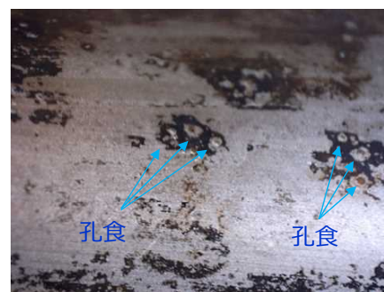
<ベローズ内面（拡大）> (ピンホール発生箇所隣の底部)
