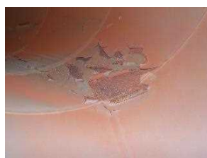
<バグフィルタB出口側煙道>
