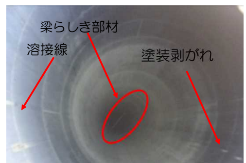
筒身内部状況
