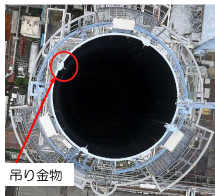
排気筒頂部状況
