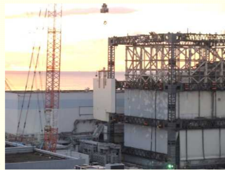
<壁パネル取外し状況>
