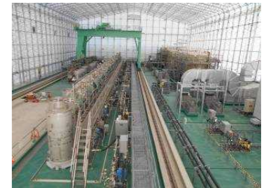
(高性能多核種除去設備)
