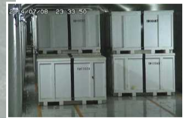
固体廃棄物貯蔵庫
