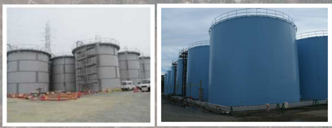
タンクの設置状況
