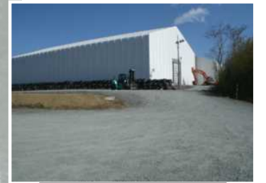
瓦礫保管テント
