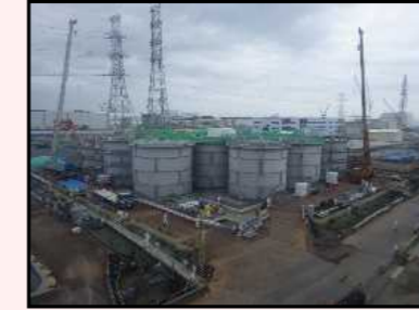
H1東エリア解体開始時の様子
