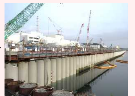
海側遮水壁 鋼管矢板打設完了状況
