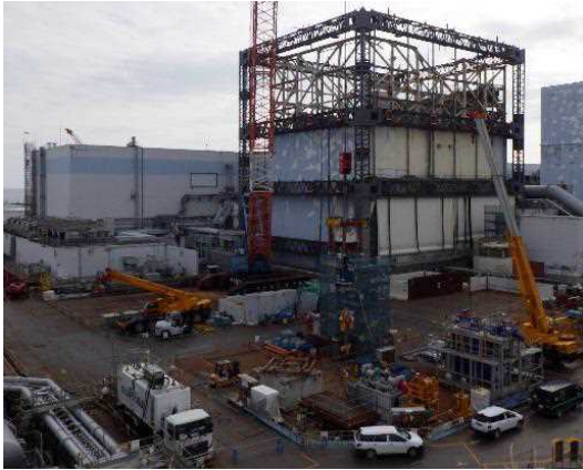
全景(北西面) 撮影：H28.11.21
