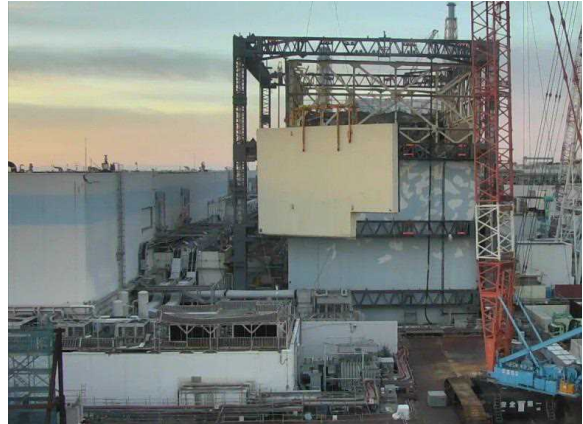
壁パネル取り外し状況（北面） 撮影：H28.11.10
