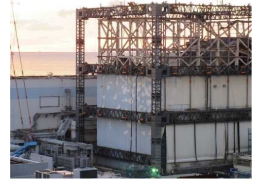
(1号機建屋カバー壁パネル取外状況)
