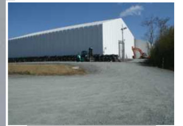
瓦礫保管テント
