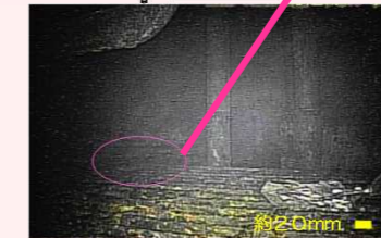
格納容器内調査状況
