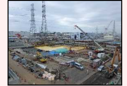
H1東エリア解体後の様子
