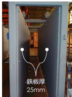
衝立形状③ (鉛板取付前)
