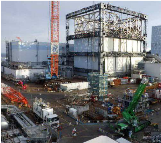
全景(北西面) 撮影：H28.12.19
