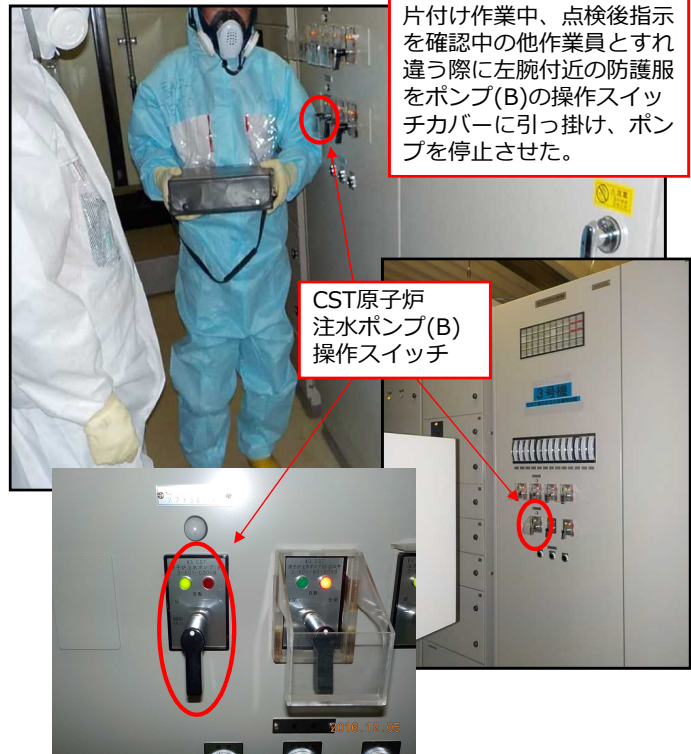
(2) 原子炉注水設備停止
