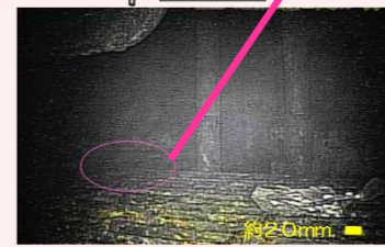
格納容器内調査状況
