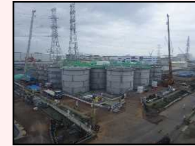
解体開始時の様子
