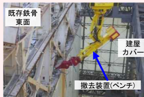
支障鉄骨の撤去作業の状況
