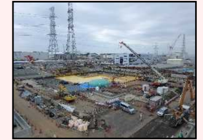
解体後の様子
