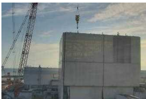
撤去装置吊り込み状況
