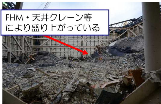
③ オペフロ全景ガレキ状況 (西方向から撮影)
