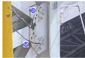
⑤梁接合部、⑥ブレース接合部 ボルトなし
