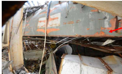
②天井クレーンガーダ(南側)中央部
