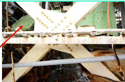
⑤南側空調機及び空調機架台
