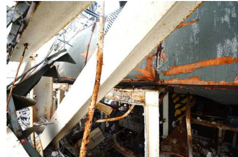
①天井クレーンガーダ(南側)
