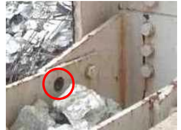
梁接合部ボルトなし
