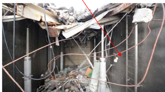
⑩DSP内部のガレキ
