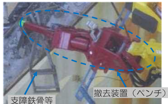
支障鉄骨等の撤去作業状況 (拡大) (作業用カメラより撮影)
