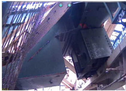
⑩ 天井クレーン北側ガーダ東側脚部
