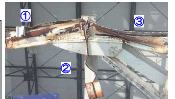
①、③梁変形、②柱フランジ外れ
