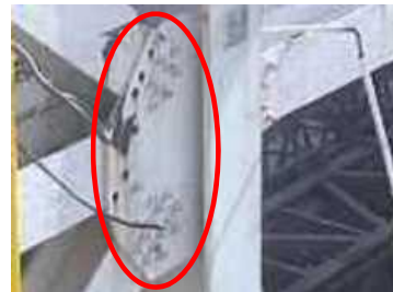
梁・ブレース接合部ボルトなし
