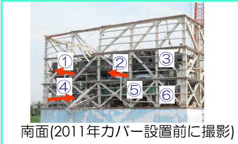
②天井クレーンガーダ(南側)中央部
