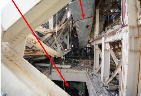
⑲オペフロ機器ハッチ開口部
