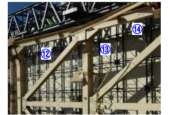
⑫梁変形、⑬柱フランジ外れ、 ⑭梁フランジ変形
