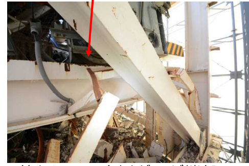
⑱天井クレーン南側ガーダ端部
