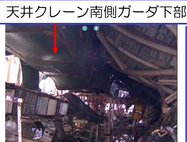
⑬ 天井クレーン南側ガーダ部
