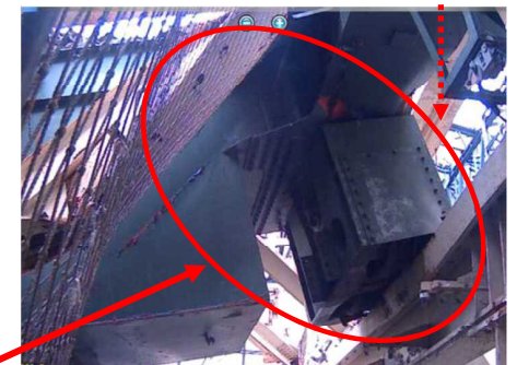
写真4 天井クレーン北側ガーダ東側外観
