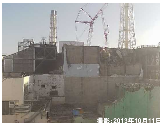
2013年10月11日オペフロ上の大型ガレキ撤去作業完了
