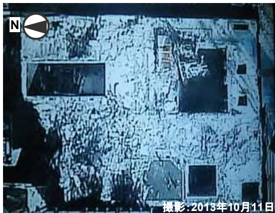
2013年10月11日オペフロ上の大型ガレキ撤去作業完了
