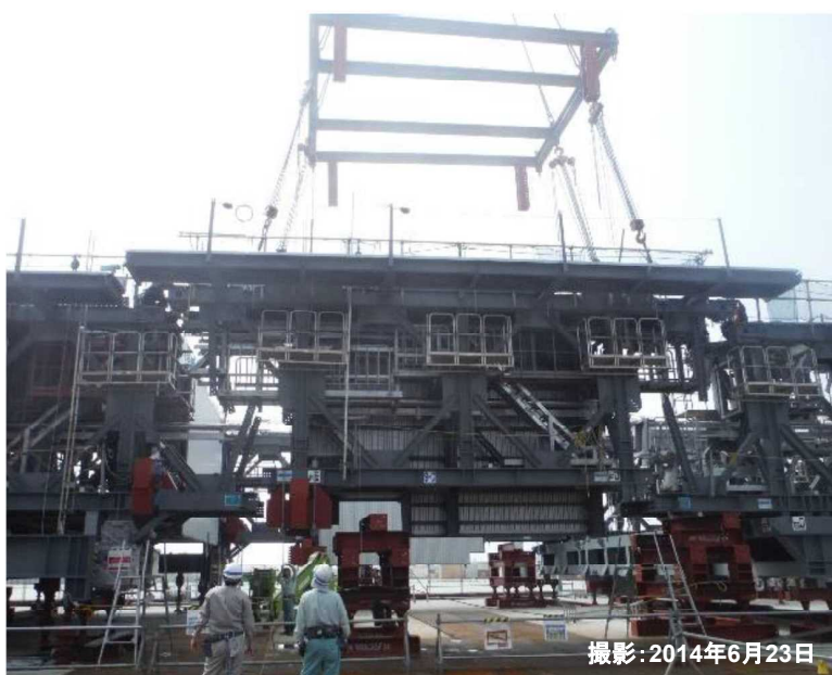
ガーダの組立状況
