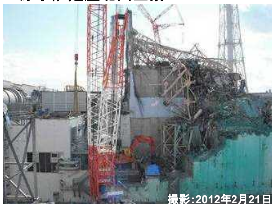
■原子炉建屋北面全景
