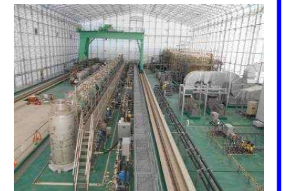
(高性能多核種除去設備)
