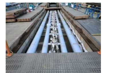
(陸側遮水壁海側 配管敷設状況)
