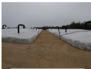
伐採木一時保管槽
