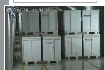
固体廃棄物貯蔵庫
