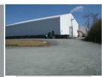
瓦礫保管テント
