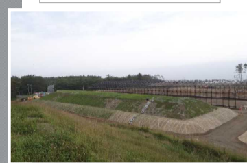
覆土式一時保管施設
