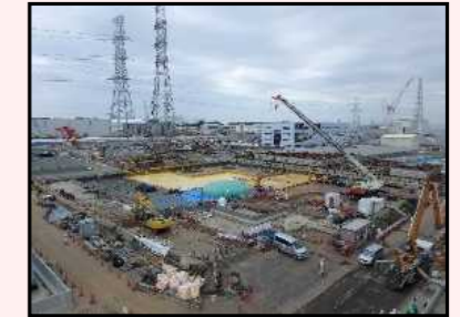
解体後の様子
