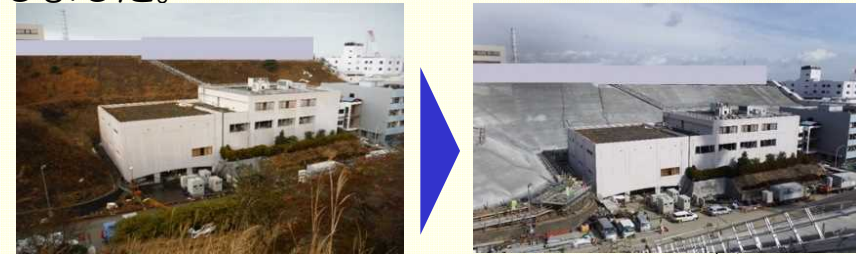
フェーシング前 フェーシング後 ＜フェーシング工事の状況＞
