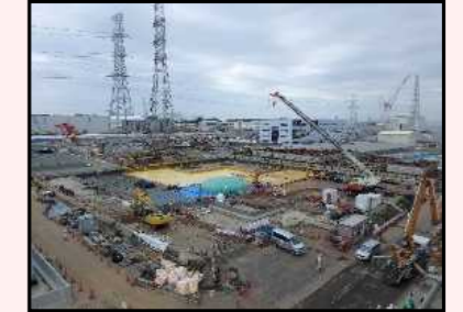
H1東エリア解体後の様子
