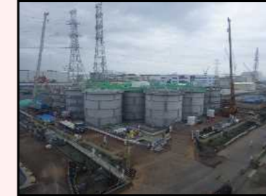
H1東エリア解体開始時の様子
