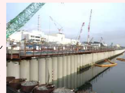
海側遮水壁 鋼管矢板打設完了状況
