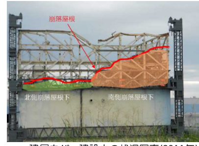
建屋カバー建設中の状況写真(2011年)
