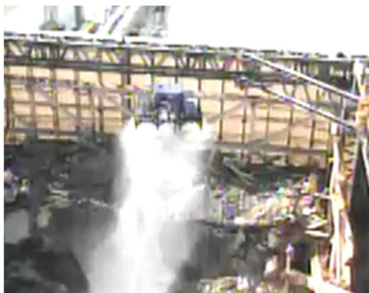
飛散防止剤散布の作業状況写真
